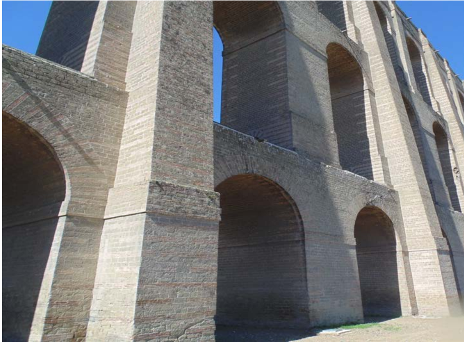
Fig. 12 Valle di Maddaloni: I Ponti - Particolare architettonico (piloni fortificati da speroni).
