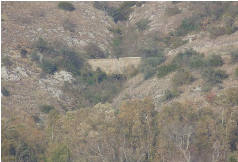
Fig. 10 Condotto Carolino: Attraversamento della faglia Garzano-Tuoro.
