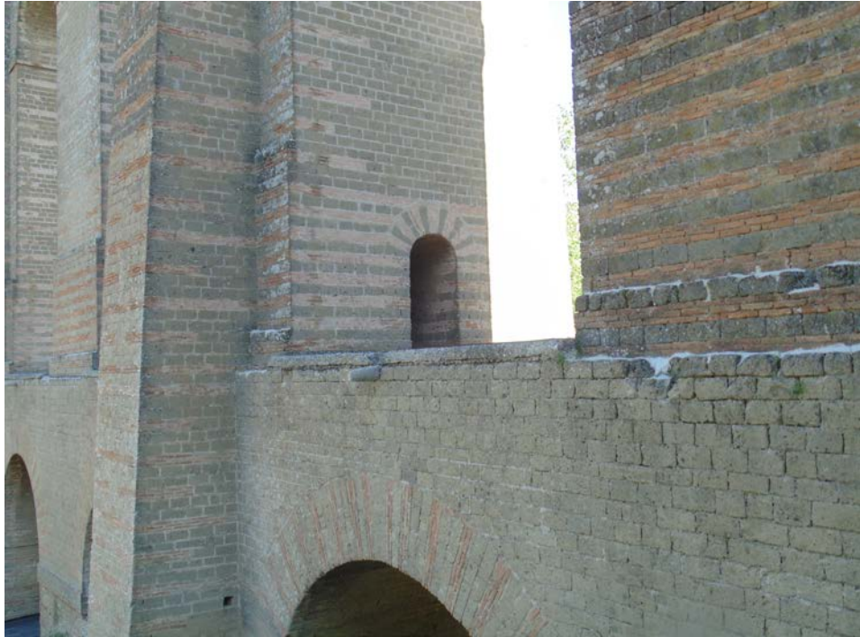
Fig. 3 Valle di Maddaloni: I Ponti – Archetto minore attraverso un pilone
